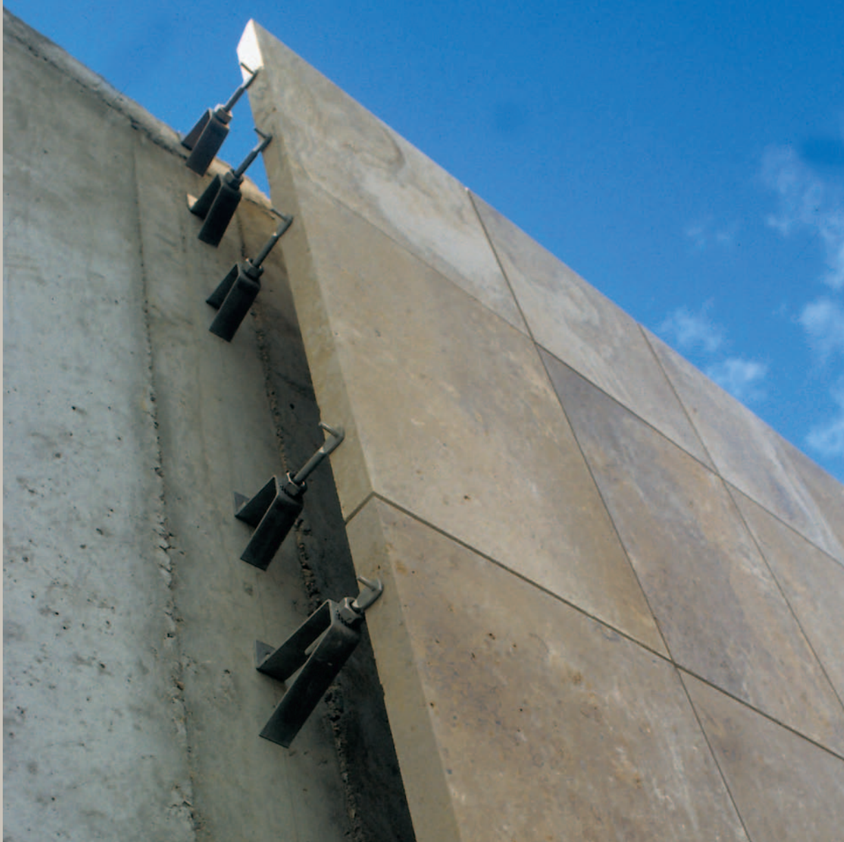
Exemple de pose avec attaches dans le joint vertical.
