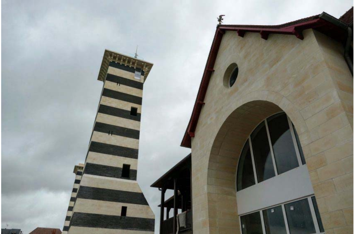
Au pied de chaque obélisque, un bâtiment. (©Le Pays d'Auge)
