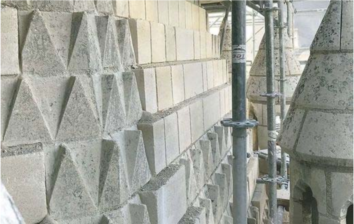
Les blocs de tuffeau ont été remplacés par de la pierre de Sireuil, plus dure et moins poreuse. - © PHOTOS : CHRISTOPHE BATARD / AGENCE 2BDM
