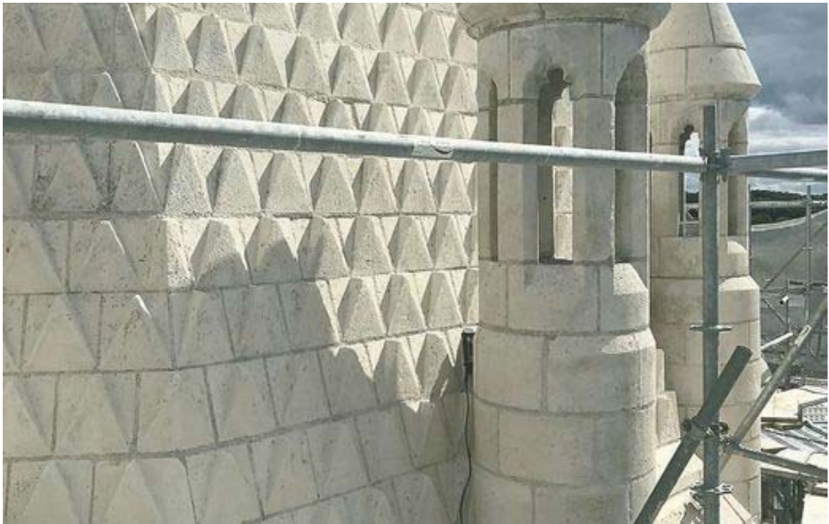
La nouvelle toiture garde malgré tout son aspect historique, notamment grâce à la taille des pierres en forme d'écailles.
