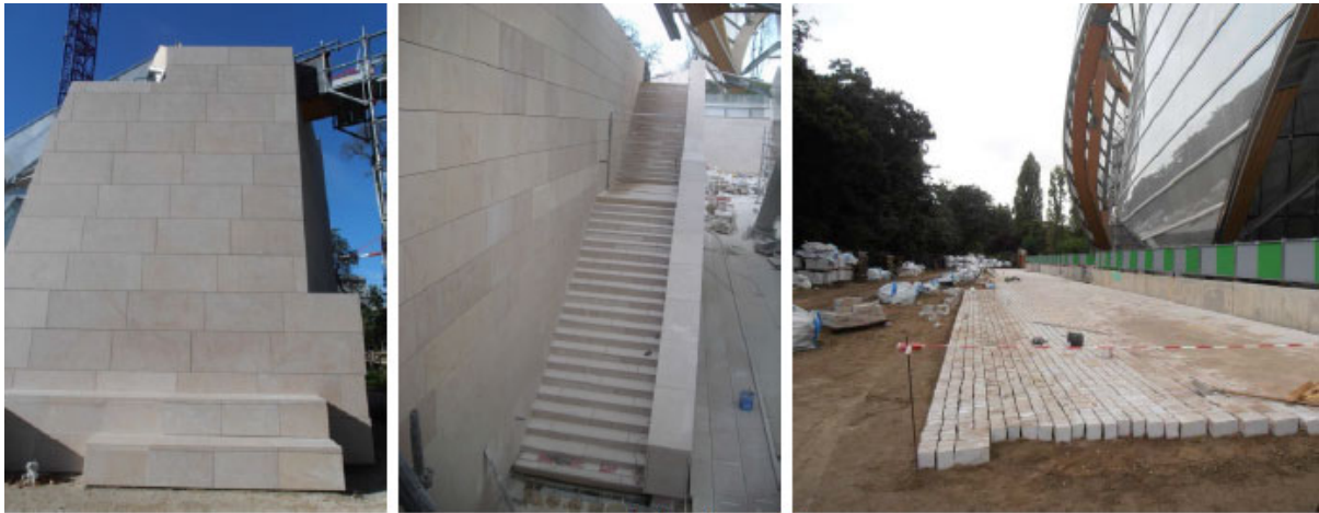
Avancement du chantier 2013/2014
