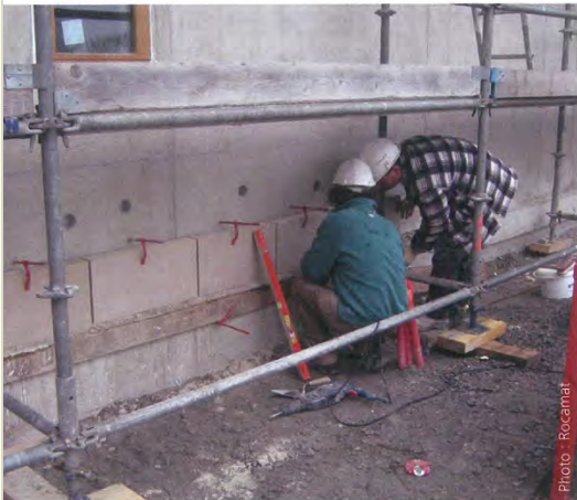
▲ Pose des pierres en pied de façade.
