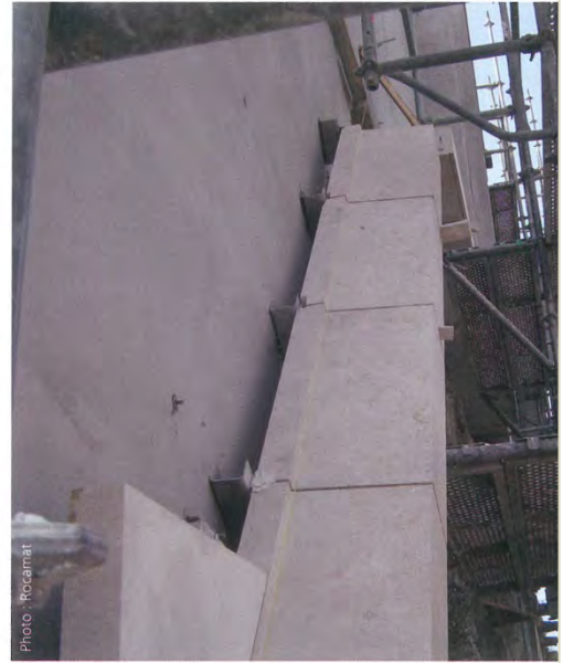
▲ Détail de la fixation des pierres.
