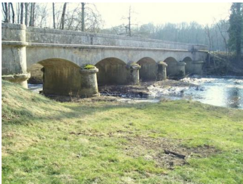
Le pont de Civry en direction de Massangis fait partie de multiples petits patrimoines (DR)
