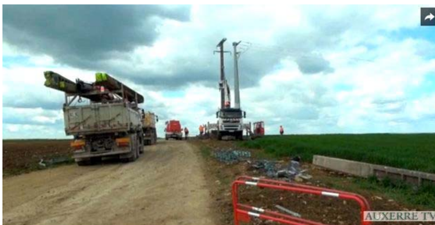
Au lieu-dit Champ des Vaches, un parc de 27 éoliennes est en voie de construction (DR)
