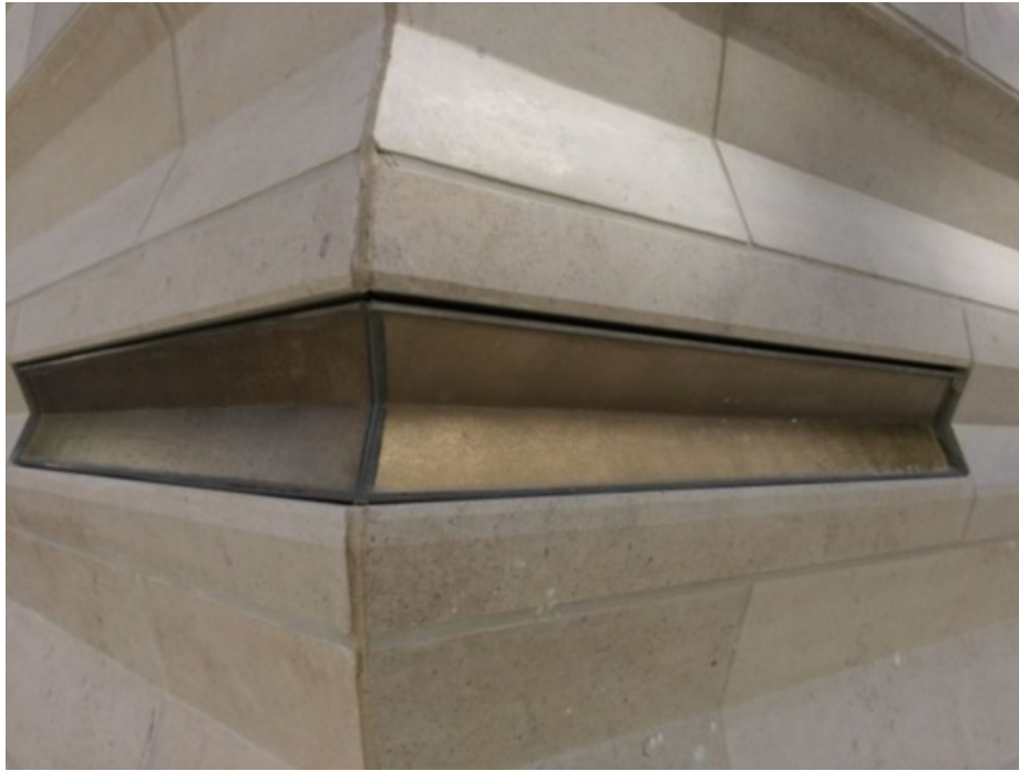
Montage de l'une des façades du CSCO et angle du CSCO
