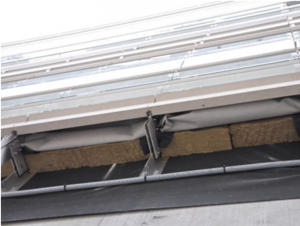
Structure porteuse en façade et Isolation par l'extérieur
