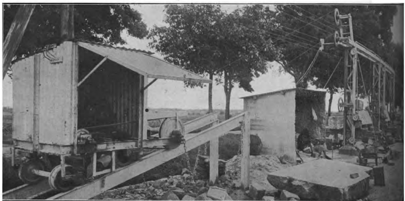
A droite le lapidaire, à gauche la mouleuse pour marches courbes
