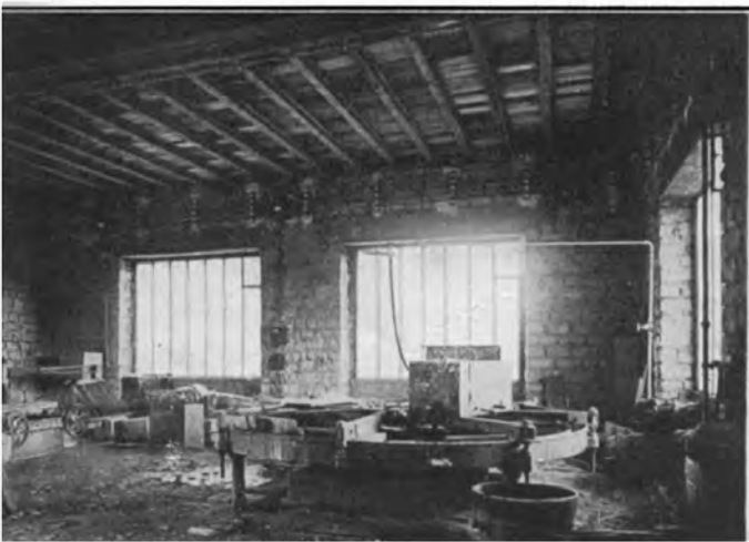
A droite le lapidaire, à gauche la mouleuse pour marches courbes
