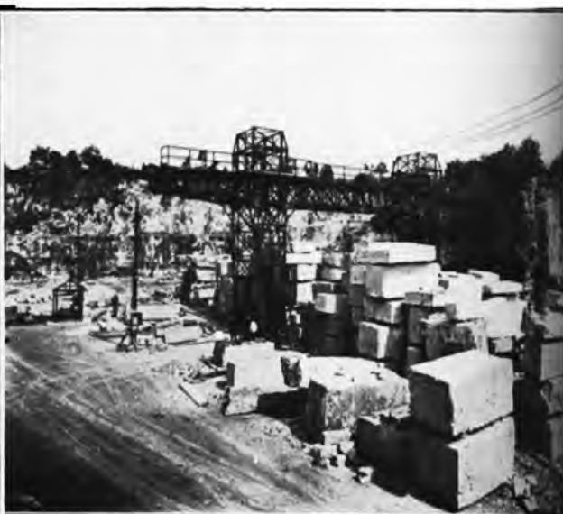
Treuil électrique fixe à la carrière Civet-Pommier et Portique roulant de 16 tonnes
