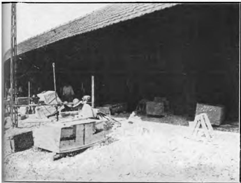
Chantier de taille couvert
