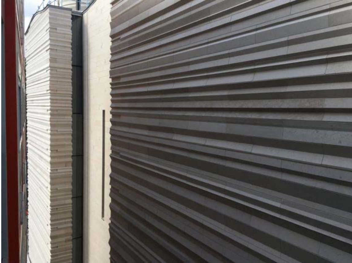
1 500 m 2 de pierres moulurées en épaisseur 15 cm habillent les 4 angles de l'église
