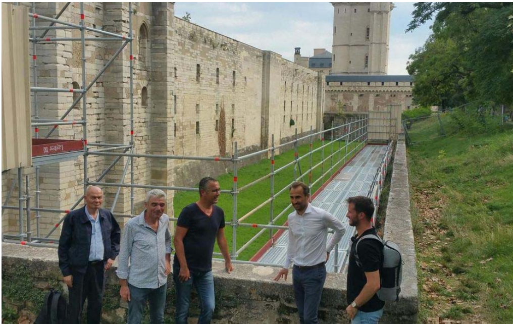
Vincennes, ce mardi. Les premiers échafaudages sont posés pour le chantier de restauration du mur de contrescarpe du château de Vincennes. Il durera 2 ans sous la houlette de Christophe Batard, l'architecte en chef des monuments historiques (2e à droite) LP/Corinne Nèves
