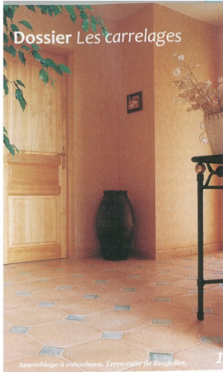
Assemblage à cabochons. Terre cuite de Ruqjölles.
