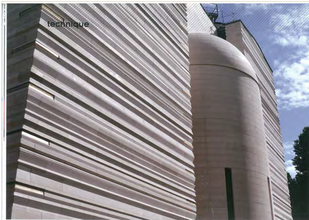
Rocamat - Centre Spirituel et Culturel Russe - usinage
