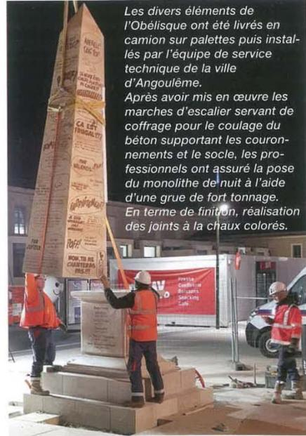
Les divers éléments de l'Obélisque ont été livrés en camion sur palettes puis installés par l'équipe de service technique de la ville d'Angoulême. Après avoir mis en œuvre les marches d'escalier servant de coffrage pour le coulage du béton supportant les couronnements et le socle, les professionnels ont assuré la pose du monolithe de nuit à l'aide d'une grue de fort tonnage. En terme de finition, réalisation des joints à la chaux colorés.
