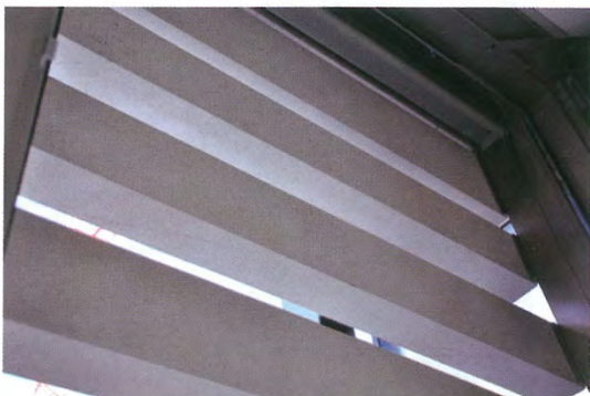
Les bandeaux de pierre animent l'extérieur des façades et jouent parfois le rôle de pare-soleil.
