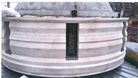
Pièces moulurées courbes pour l'habillage de la base des bulbes.
