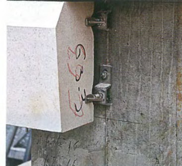
Découpe au jet d'eau des éléments de la rosace par l'entreprise Sermab. La pose a été réalisée par FGPM.
