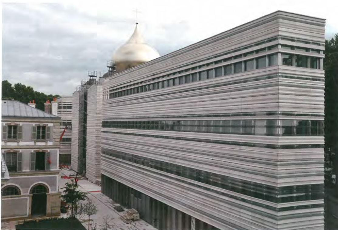
Les trois bâtiments Rapp, Université et Branly sont habillés de 2 500 m 2 de pierre de Massangis Claire Nuancée, finition adoucie, dont 2 100 m 2 , soit 5 555 bandeaux moulurés en 10 cm d'épaisseur. Ils ont été posés "en porte-manteau" sur un mur rideau Permasteelisa.
