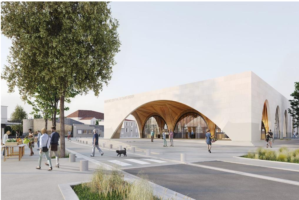
Marché couvert, Saint Dizier (52) 2019/chantier en cours – Studiolada, Christophe Aubertin & Aurélie Husson arch. Pierre calcaire de Meuse et bois résineux des Vosges @ Studiolada
