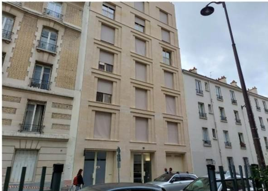
Rue des Cévennes (XV e ), samedi. Entièrement construit sur les ruines d'un ancien garage, réhabilité pour 2 millions d'euros, cet immeuble en pierre de taille comporte neuf logements sociaux, gérés par la RIVP.
